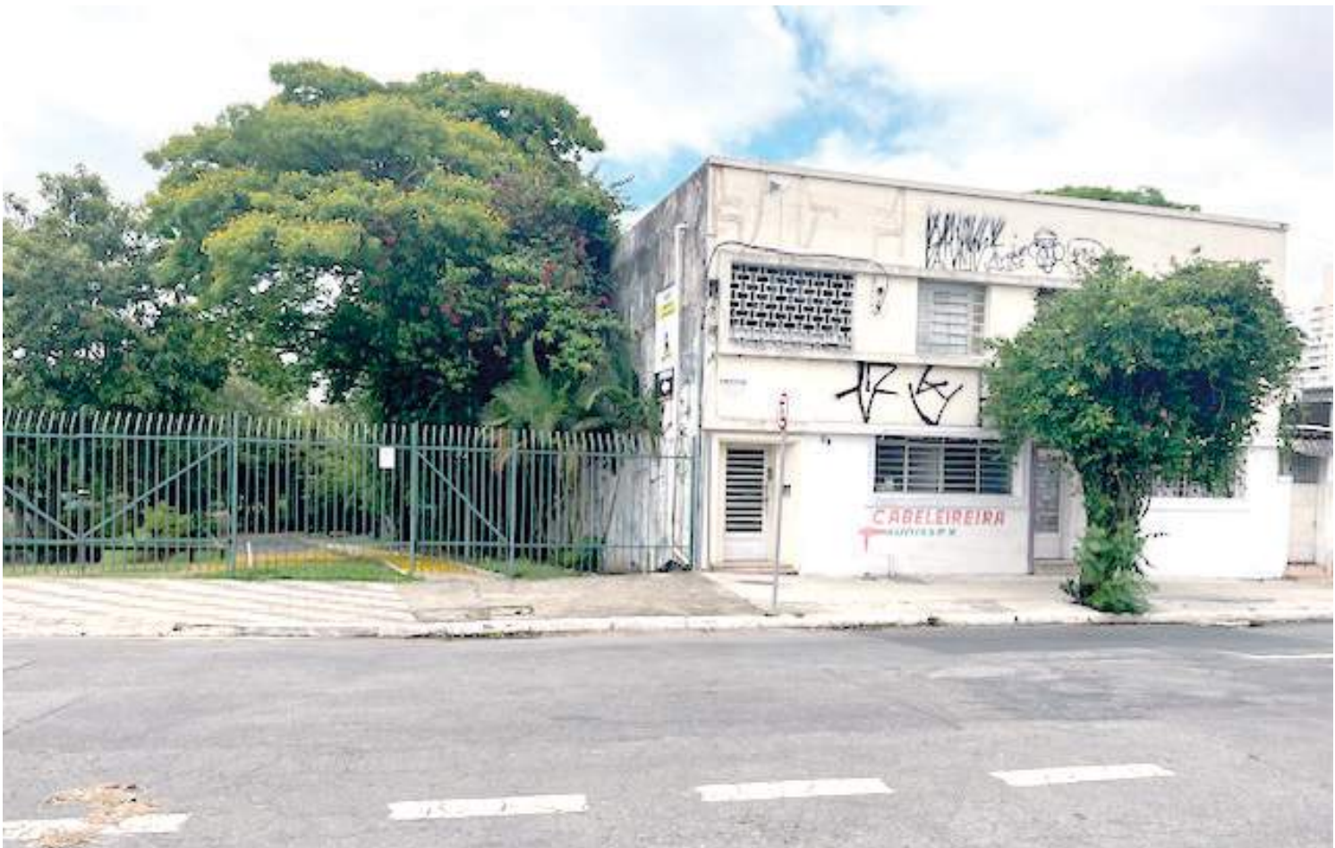
Espaço na esquina da rua Leais Paulistanos terá passagem subterrânea para saída da estação Parque da Indenpendência
