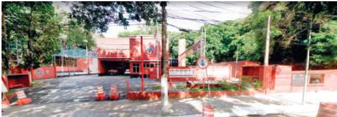
A sede do corpo de bombeiro fica localizada a Avenida Nazaré, a 8 metros do museu
