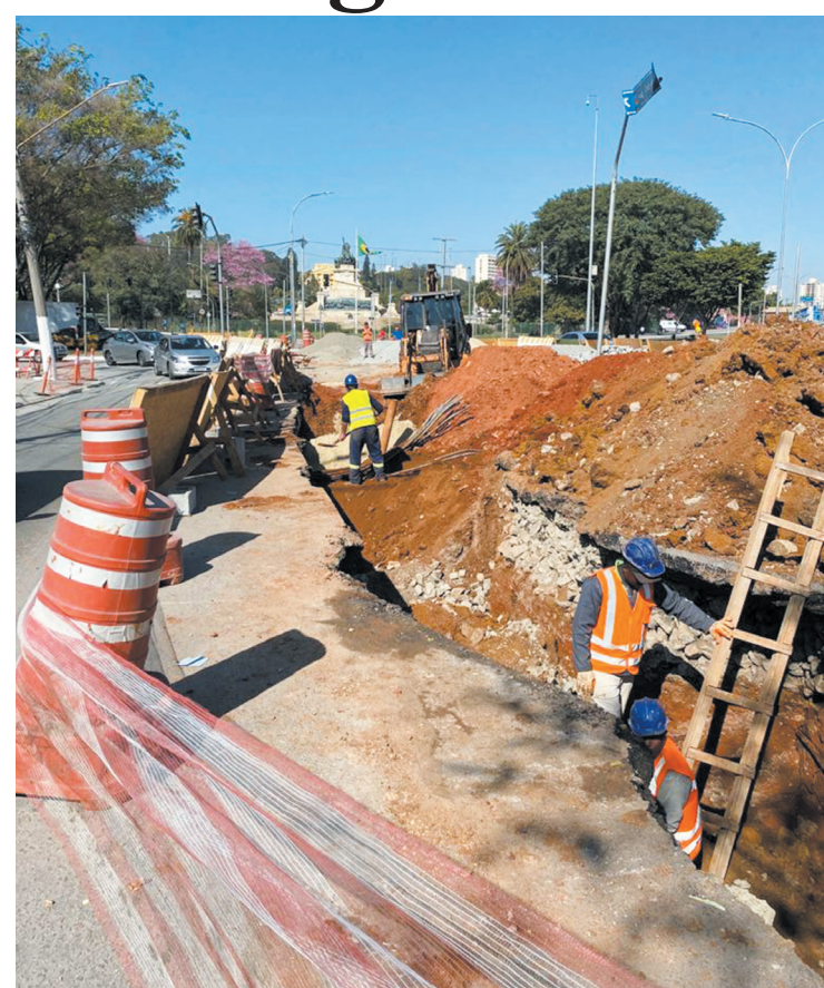
A previsão para a conclusão dos trabalhos é de 25 dias
