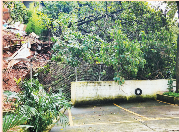
Terreno no Jardim Vergueiro desaba em tragédia anunciada
