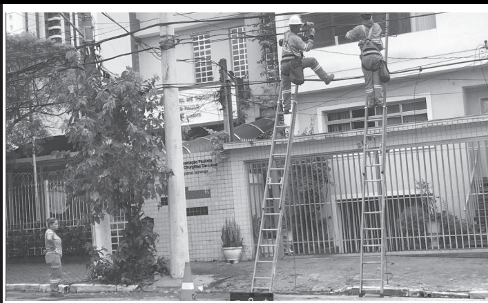
Funcionários da Claro realizam manutenção da rede
