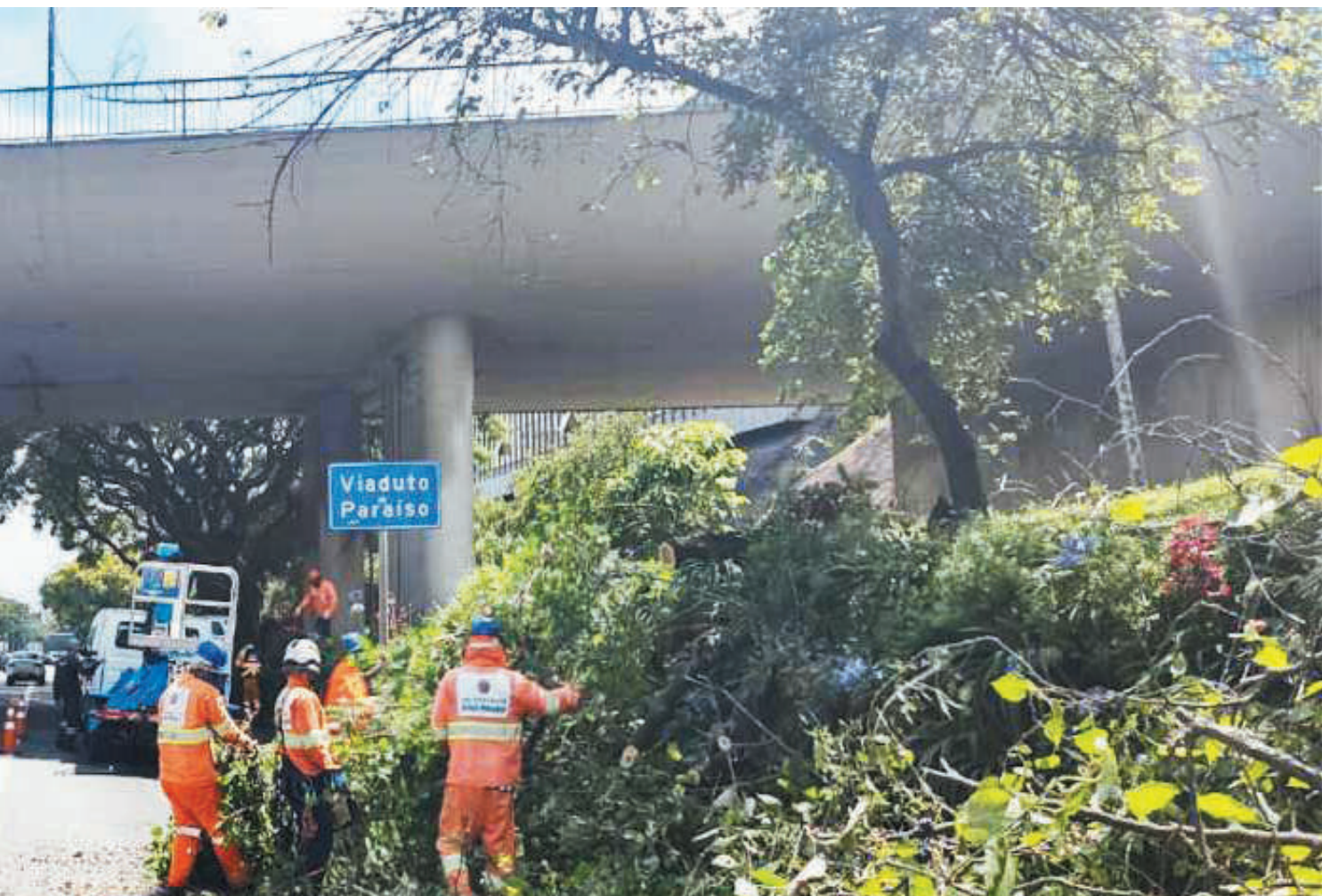
Equipes realizam tarefas para tentar reduzir impacto das chuvas na parte da Avenida que fica embaixo do Viaduto Paraíso
