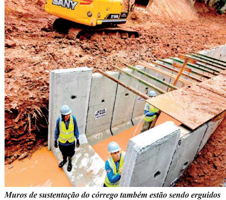
Muros de sustentação do córrego também estão sendo erguidos
