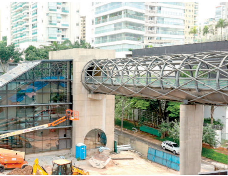
Obras da Estação Vereador José Diniz estão bem avançadas
