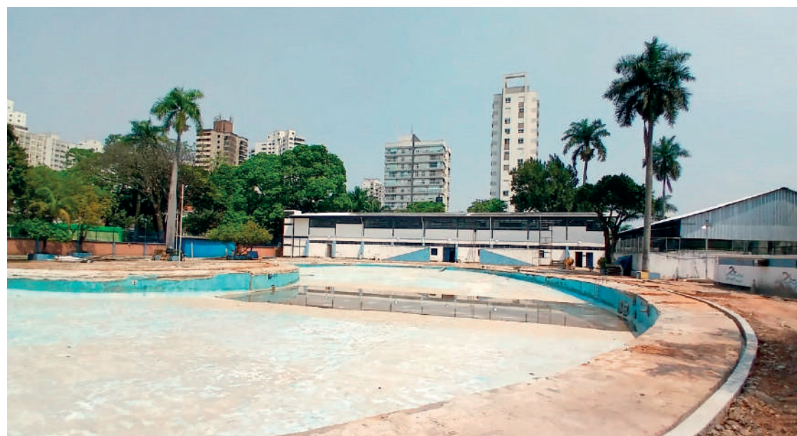
Obras vão transformar o local em um espaço moderno e completo ainda mais atrativo para o público
